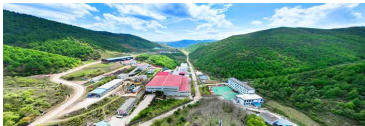
西和中宝矿区生态环境治理
